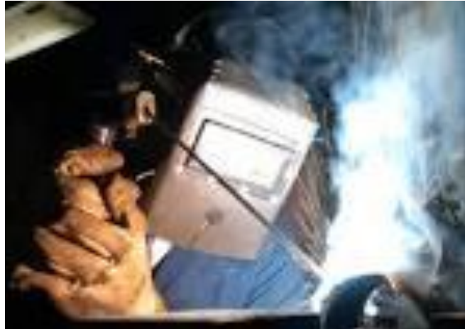
Figura 4.2.- Proceso de soldadura SMAW
