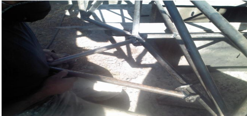
Figura 4.18.- Colocación de la mesa inferior
