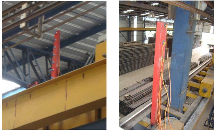
Figura 2.140: Montaje y conexión de los sensores inductivos
