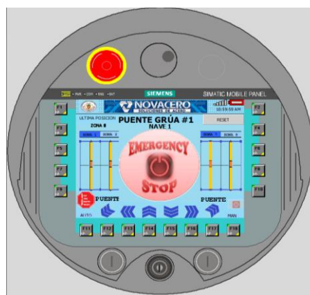
Figura 3.2: Señal de paro de emergencia – HMI controlador del puente grúa
