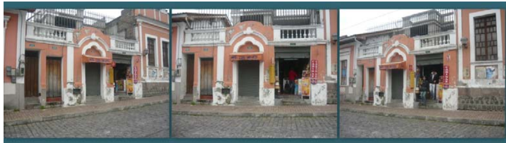
Figura 3.23. Fotografías convergentes de la estructura Este 02.
