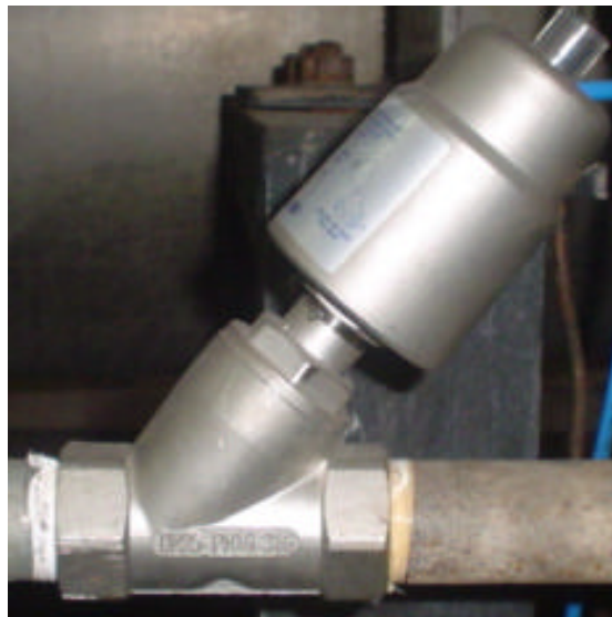
Figura. 2.28. Válvula con actuador neumático de asiento inclinado
