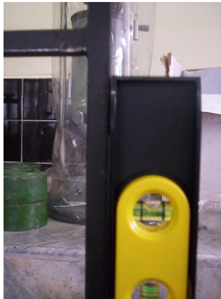
Figura 4.60 Verificación de elementos verticales con nivelador
