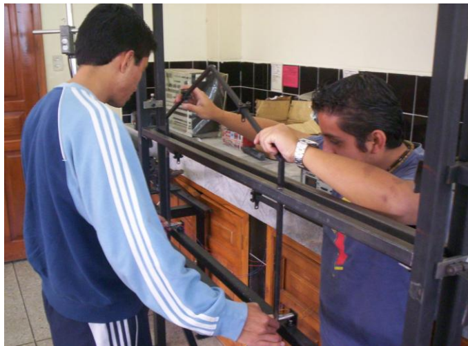
Figura 4.57 Ensamble de pórtico en apoyos
