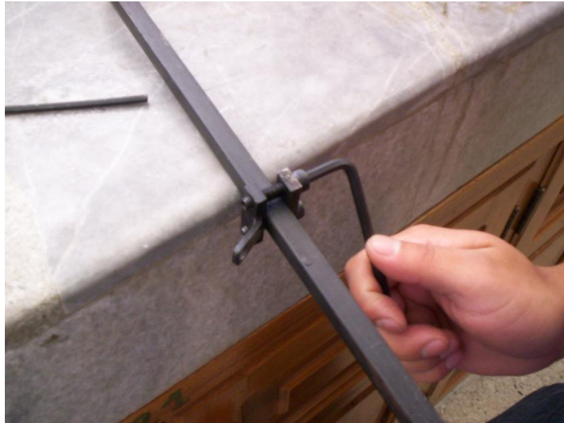
Figura 4.46 Acople de ganchos en elementos
