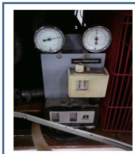
Figura 3.9 Termostato lado frío.
