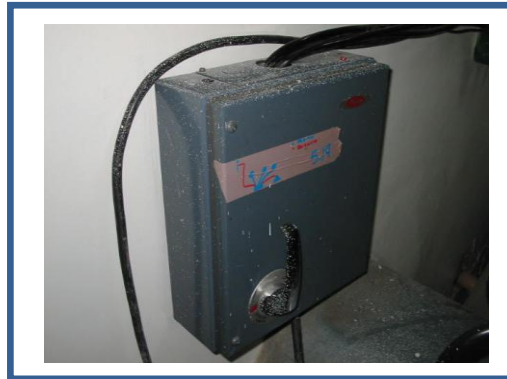
Figura 3.2 Alimentación eléctrica principal del banco de transferencia de calor.
