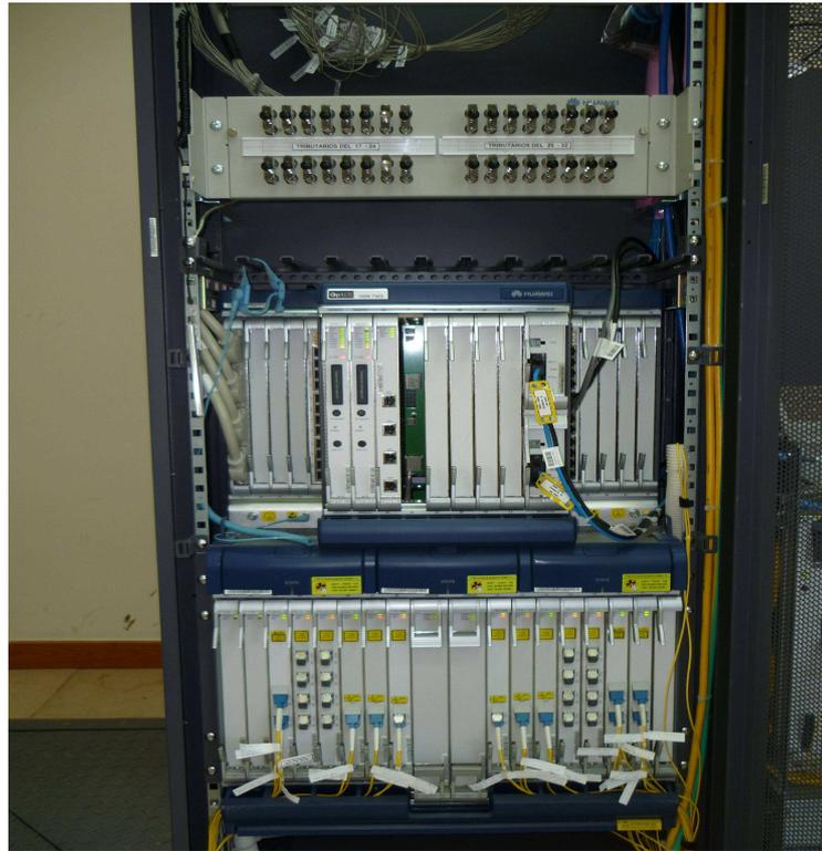
**Figura 3.6.** Fotografía equipo Huawei OSN 7500
