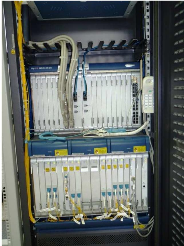
**Figura 3.5.** Fotografía equipo Huawei OSN 3500
