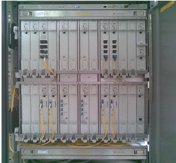
**Figura 3.3.** Fotografía equipo Siemens Surpass hiT7070
