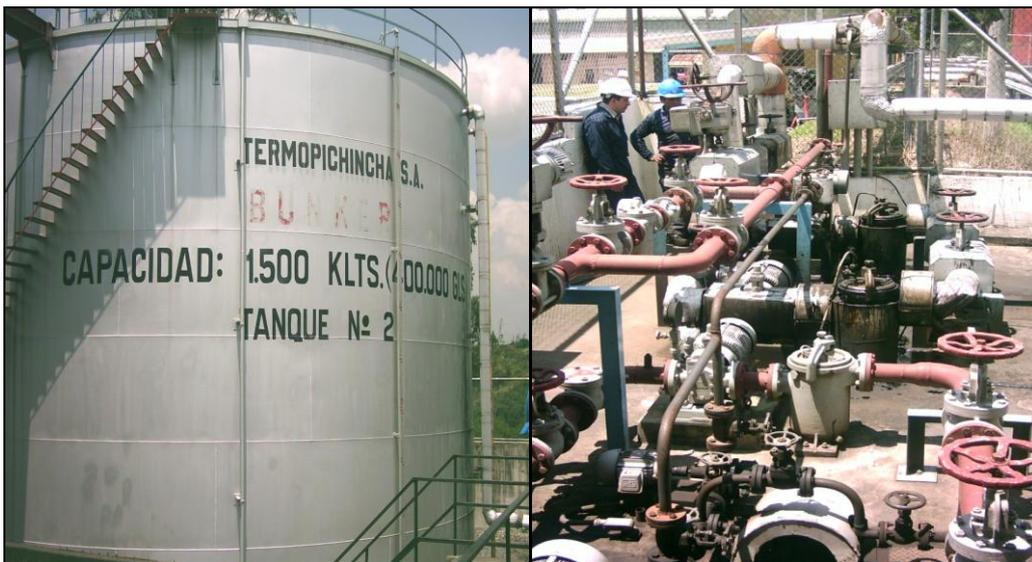
Fotografía 4.2 Componentes del sistema de suministro de combustible.
