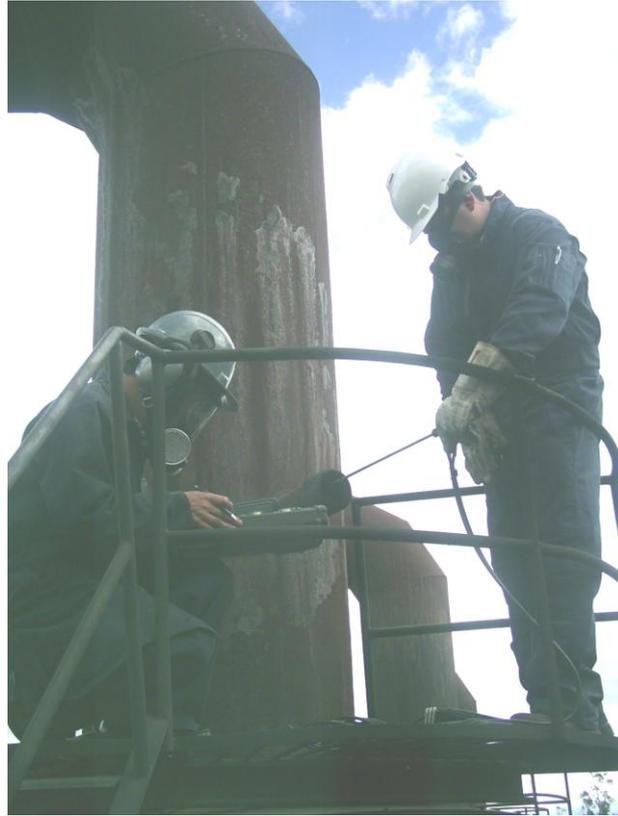
**Fotografía 5.8 Toma de datos con equipo TESTO 350 M/XL CONTROL UNIT en la chimenea del motor Nro. 3**
