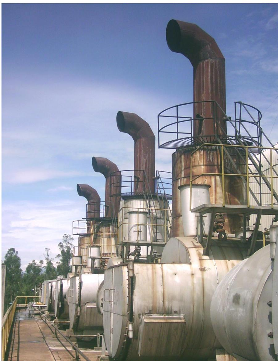
**Fotografía 5.1 Chimeneas de los motores 1, 2, 3, 4, (Nótese que cumplen con el requisito para la ejecución de medición que la norma ambiental exige).**
