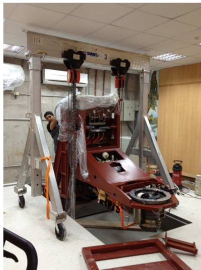
Figura 4. 22 Instalación del Gantry Sobre la Base
