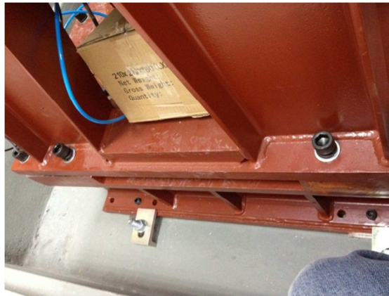
Figura 4. 23 Fijación del Gantry sobre la Base
