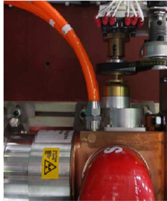
Figura 4. 37 Instalación del sistema de refrigeración del Magnetrón
