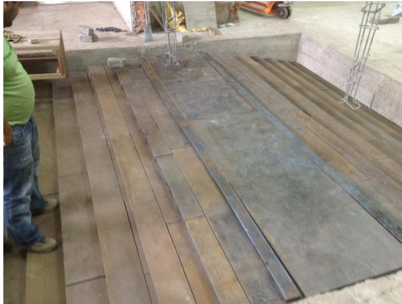
Figura 2. 16 Colocación de las Planchas de Acero en sitio
