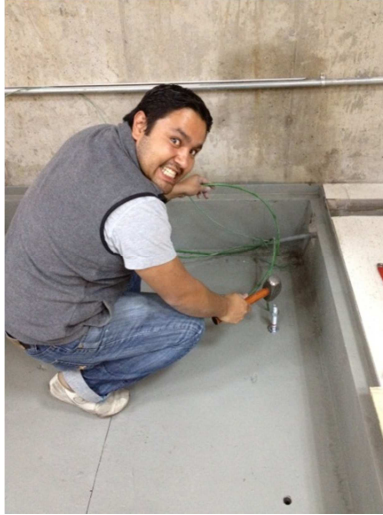
Figura 4. 13 Colocación de los tornillos de fijación
