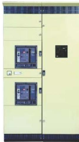
**Figura 4.14** Transferencia automática de tensión Merlin Gerin en tablero FUENTE: Catalogo Merlin Gerin 2004
