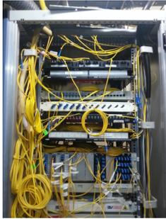
Figura 8: Patch cords instalados
