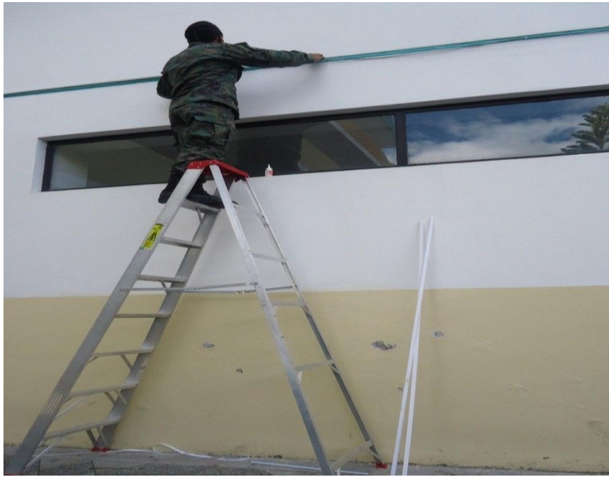
Instalación de los canales de la red.
