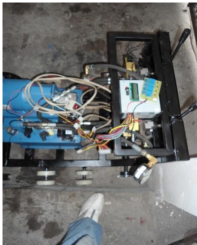
Figura 7 Montaje e instalación del circuito electrónico
