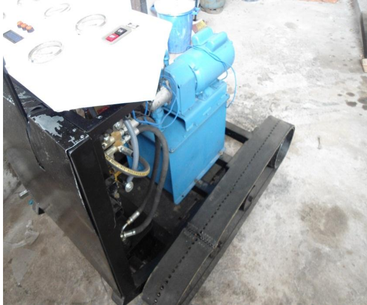
Montaje del tablero de control
