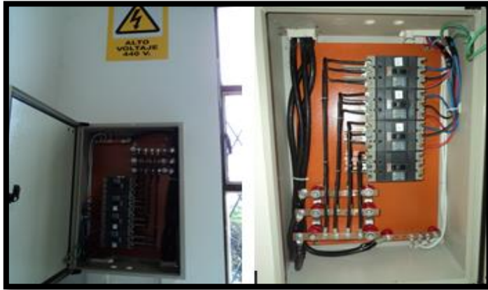
Figura 2.29: Alimentación principal para el KUKA KR 16.
