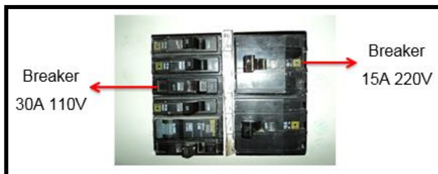
Figura 2.28: Tablero principal de distribución.
