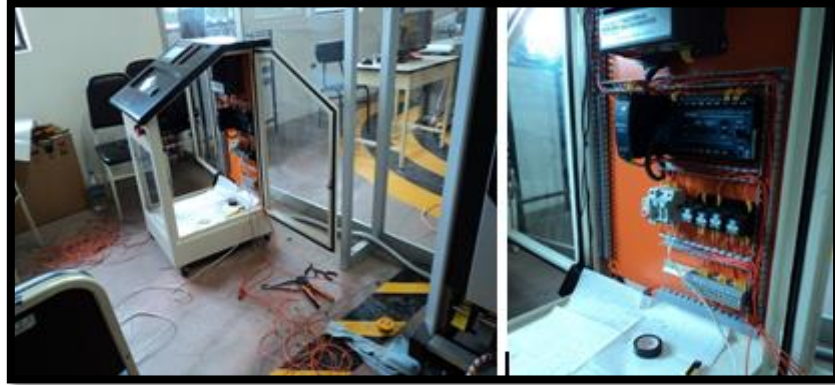
Figura 2.26: Colocación y cableado.
