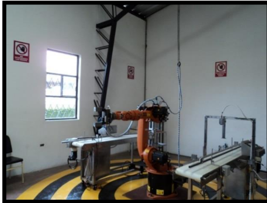
Figura 2.48: Señalización en la celda de manufactura.
