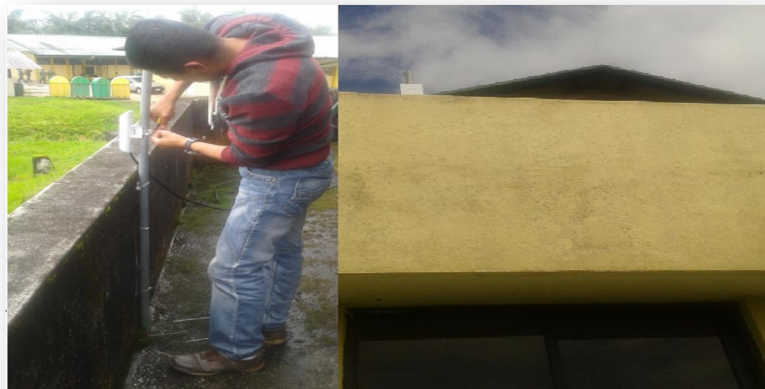
Figura 4.31: Instalación de Antena receptora en el casino.
