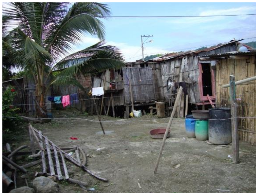
Foto 4.10: Estructura física, Barrio La Esperanza casas con estructura de caña y zinc.
