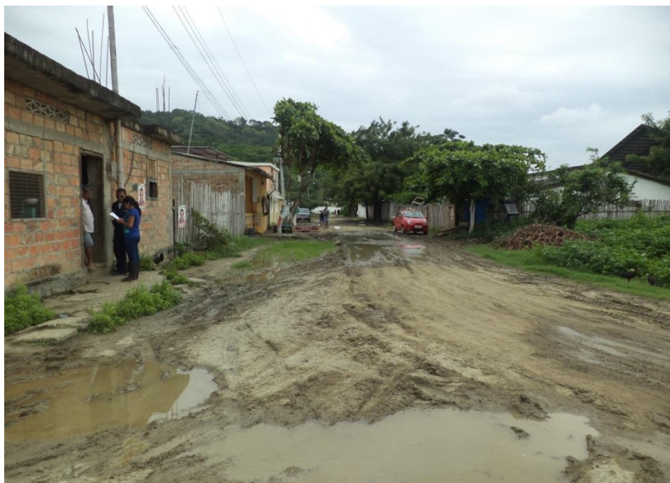
Foto 5.19: Barrio La Pega, estancamiento de aguas lluvia en las vías.
