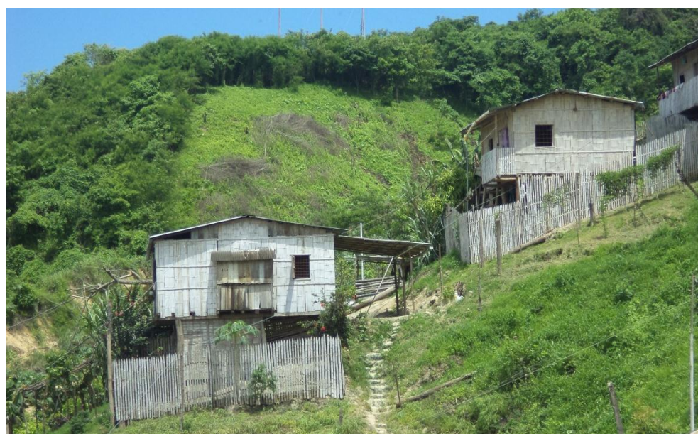
Foto 4.12: Barrio 11 de Diciembre, forma de construcción irregular.
