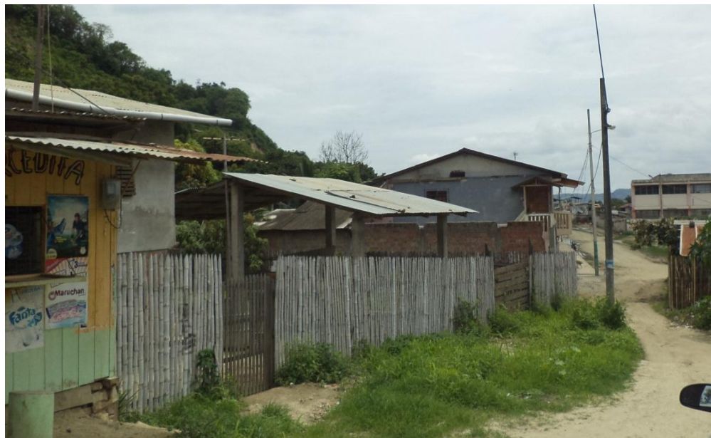
Foto 4.11: Barrio Los Perales, se encuentra bajo el nivel de la calzada.
