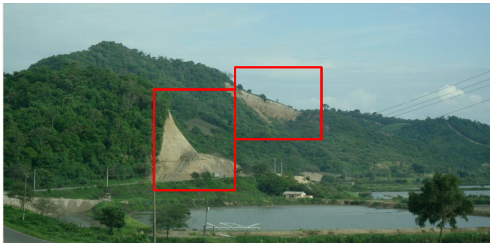
Foto 4.3: Vía Chone, en esta vía se pueden presenciar varios deslizamientos
