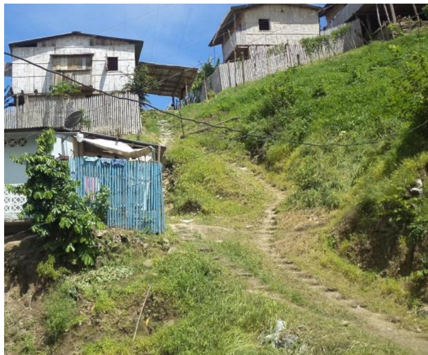
Foto 5.2: Barrio 11 de Diciembre falta de mantenimiento vial y ensanchamiento de la misma, no cuenta con un acceso vial adecuado para la comunidad.
