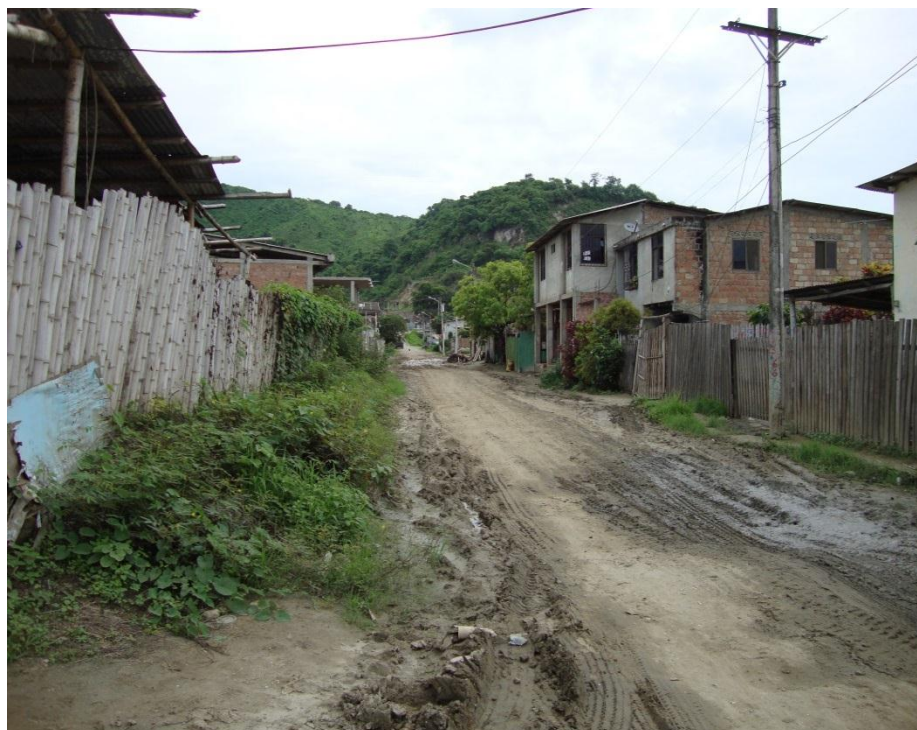
Foto 5.6: Barrio Los Perales falta de mantenimiento vial, vías con lodo.
