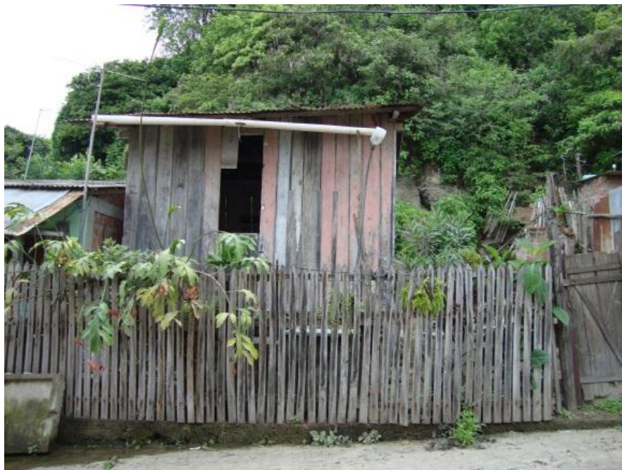
Foto 4.9: Estructura física, Barrio 5 de Junio casas con estructura de madera y zinc.
