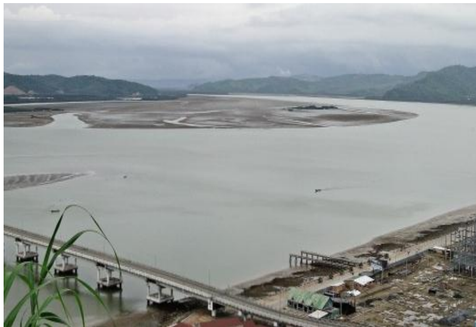
Foto 5.22: Vista desde los tanques, Perdida de la calidad del agua y exceso de sedimentación del Estuario del Río Chone
