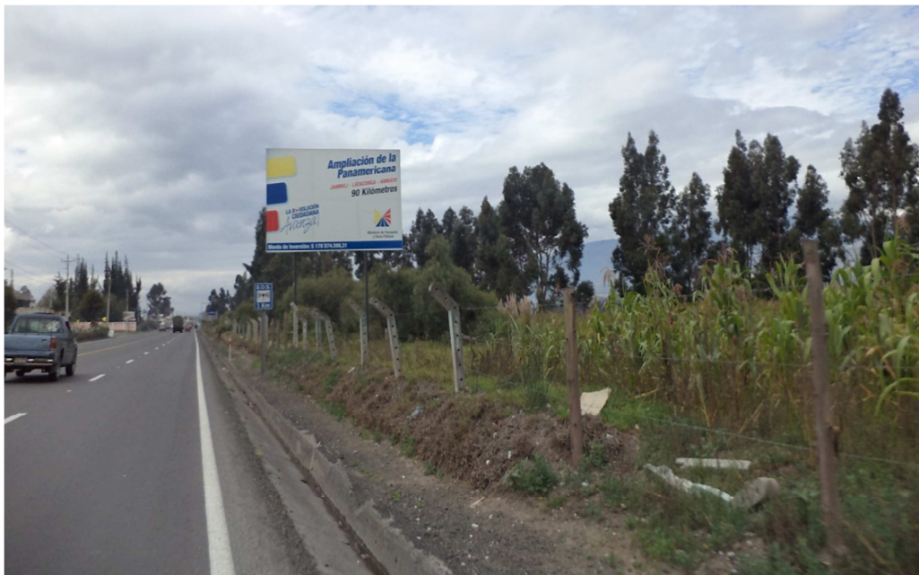
Figura 5.9 Ampliación Panamericana Jambelí-Latacunga-Ambato
