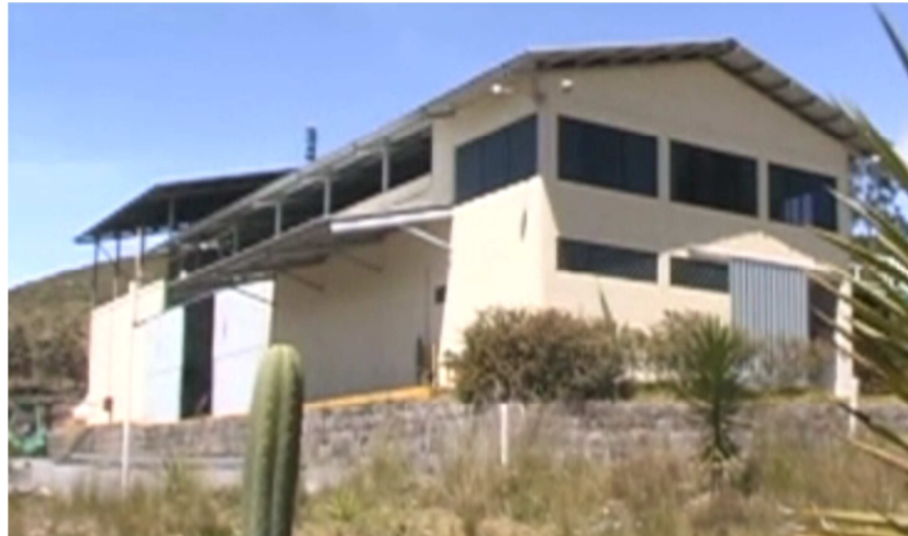
Figura 1.3 Nave Principal y oficinas
