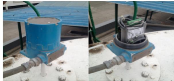
Figure 11. Radares instalados en tanques
