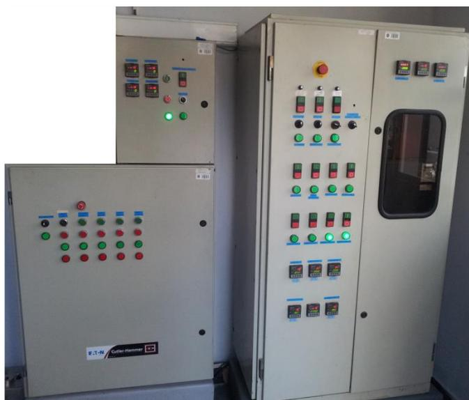
En la figura 4.1, se puede observar a la izquierda, las pantallas de visualización para las temperaturas, así como los pulsadores que prenden y apagan las bombas conectadas en este sistema, además las cajas contienen en su interior transformadores de energía y variadores de velocidad para el molino de mezcla de un banco de pruebas externo.
