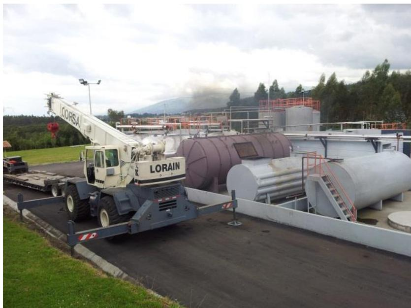
Los tanques horizontales de almacenamiento de asfalto (figura 2.11.) fueron fabricados bajo la norma UL-142 Norma para tanques de acero sobre el suelo para combustibles líquidos y líquidos inflamables (Standard for Steel Aboveground Tanks for Flammable and Combustible Liquids) mientras que los tanques verticales de emulsión fueron fabricados bajo normas API 650 Tanques soldados de acero para almacenamiento de petróleo (Welded Steel Tanks for Oil Storage).
