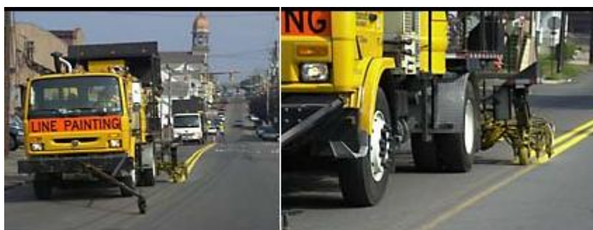
Figura 3.3 Pintado de líneas con pintura a base de agua
