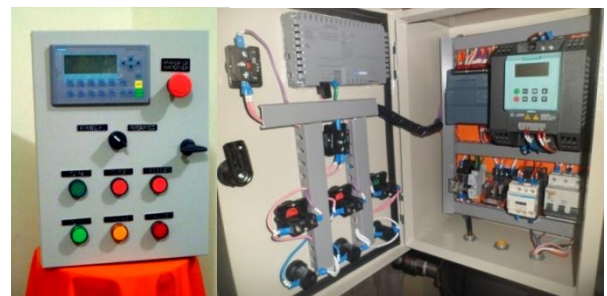
Fig. 13. Implementación eléctrica y electrónica
