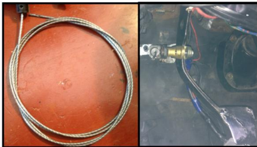
Figura 4.40: Inspección del cable de acero
