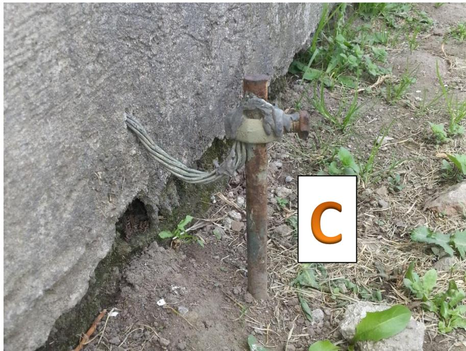
**Figura 33.- Conexión a la varilla C con perno.**
