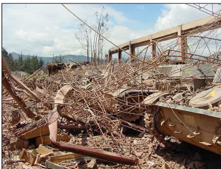
Figura 5. Destrucción de un hangar con vehículos blindados luego de la explosión ocurrida el 20 de noviembre de 2002.
