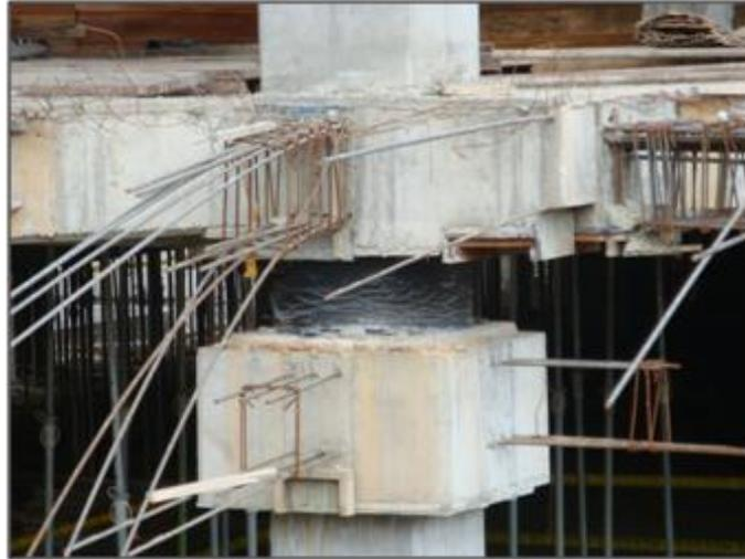
Figura 38 Aislador sísmico en Centro Médico Imbanaco
