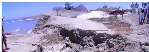
**Figura 12.** Vía o acceso vehicular construido en Agosto y Septiembre de 2010, la foto indica que la obra no tuvo planes de prevención y selección de sitios adecuadas para construcción vial.
