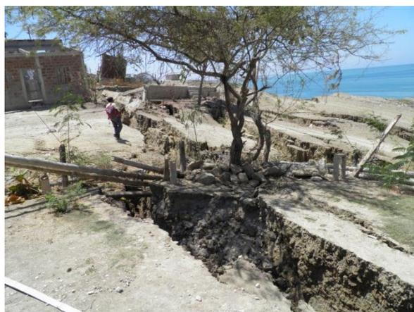
**Figura 8.** Grietas profundas alcanzan el metro de ancho y cerca de 10 metros de profundidad, producto del desprendimiento del 07.04.2011.
