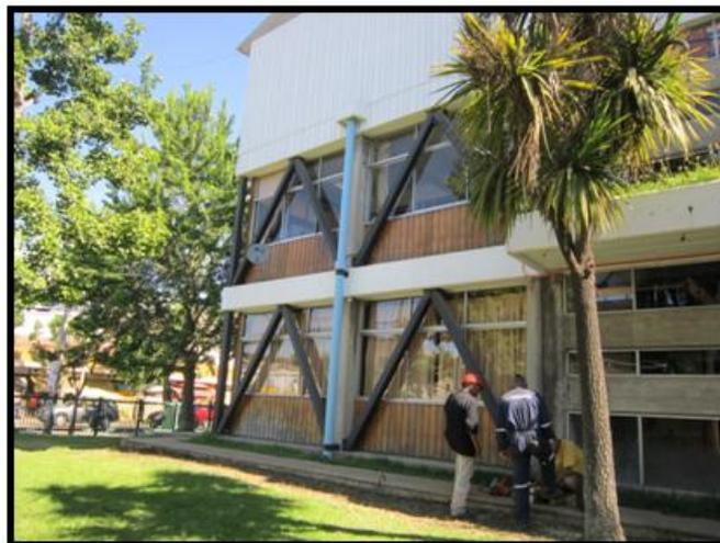
**Figura 33** Edificio reforzado con perfiles en “V” invertida (Chile)
