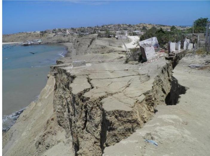
**Figura 9.** Vista panorámica mostrando la dimensión del desprendimiento del acantilado y el colapso de estructuras edilicias.
