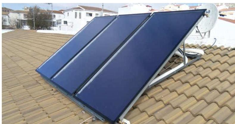
**Figura 1.4.** Panel Solar Térmico.
