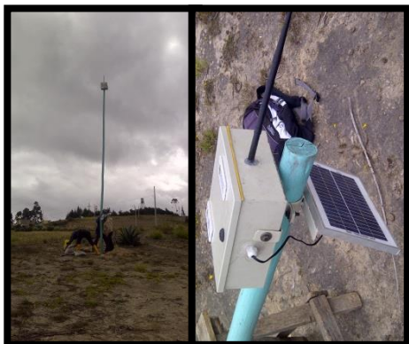
Fig. 29: Instalación Repetidores
