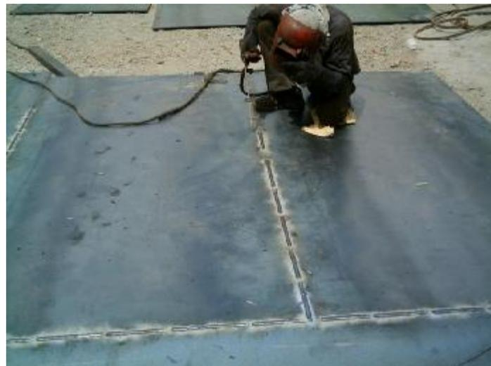
**Figura 4.2:** Soldadura de las planchas.
