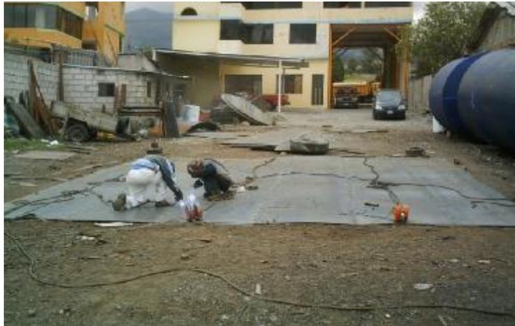
**Figura 4.4:** Soldadura intermitente en las planchas del cuerpo.
