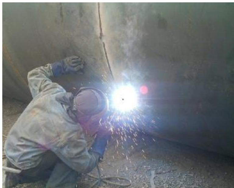
**Figura 4.11:** Soldadura externa del tanque.
