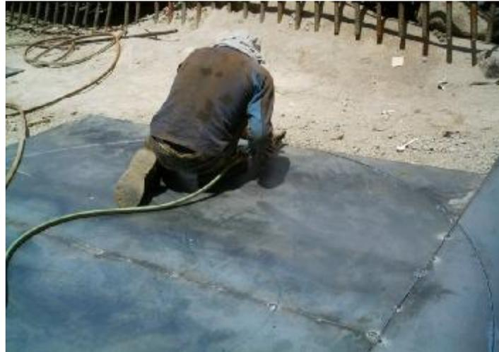
**Figura 4.1:** Corte de las planchas acero.
