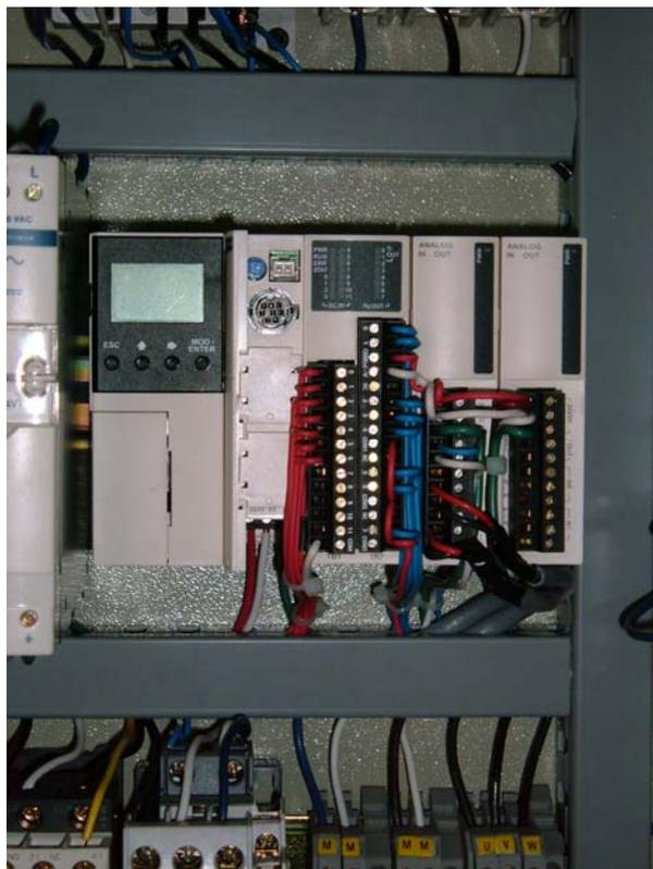
Fotografía 1 Conexiones del PLC
