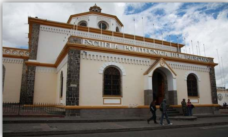
Imagen N° 01: Edificio Central ESPE-L
