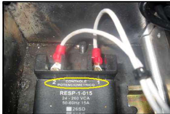
Figura 5.40. Conexión de los pines del control de potenciómetro
