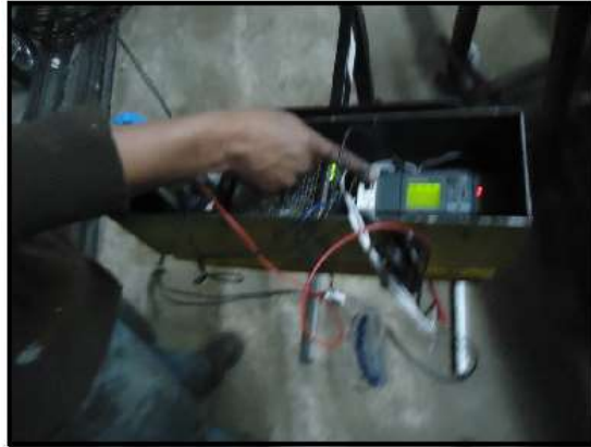
Figura 6.2. Revisión de cables y conexiones
