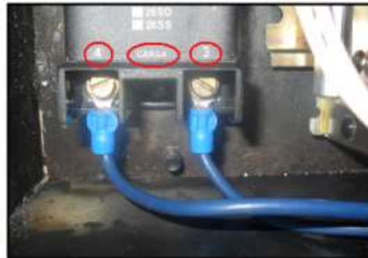
Figura 5.41. Conexión de los pines de carga
