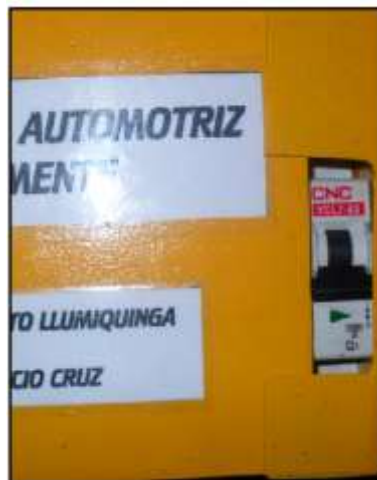
Figura 5.43. Montaje del breaker
