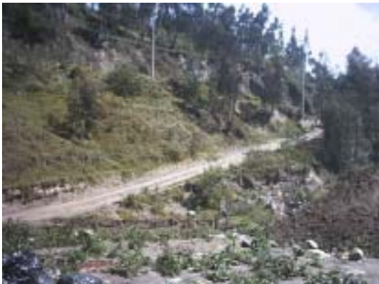
FOTO N°5 VIA INTERNA DEL RELLENO
