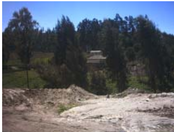
FOTO N°7 PLATAFORMA DE DESCARGA DE RESIDUOS
