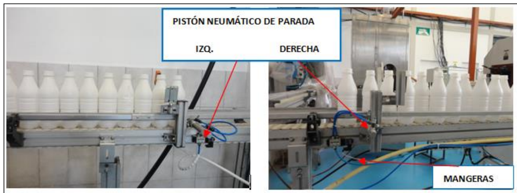
Figura 3.13 Montaje de elementos neumáticos. Elaborado por: Roberto Guishcasho y Javier Pilamonta
