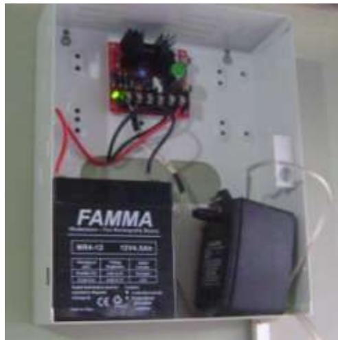
Foto.12: Fuente de poder con batería auxiliar
