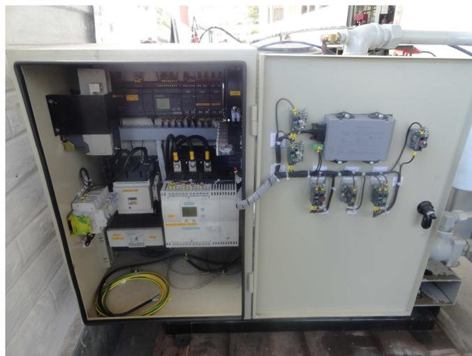
Foto 22. Tablero Instalado
