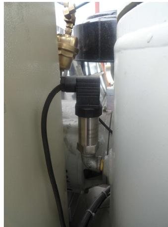
Foto 3. Transmisor de Presión en el tanque separador
