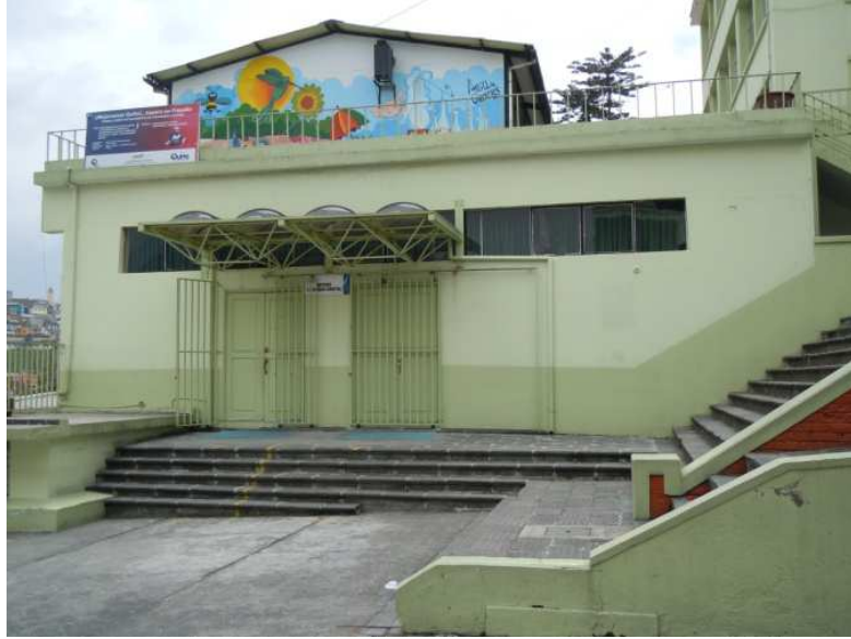
Figura 2 Vista de la estructura sobre el auditorio
