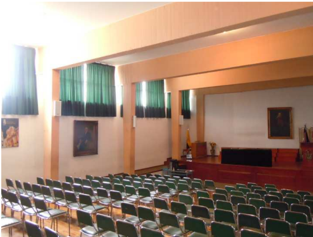
Figura 1 Vigas y columnas del auditorio
