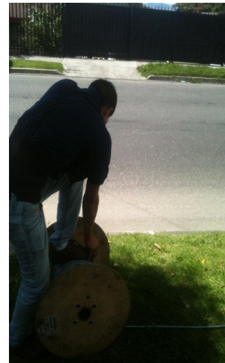
Fig. 7. 2 Proceso de bobinado manual de cable AWG 7
