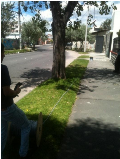
Fig. 7. 2 Proceso de bobinado manual de cable AWG 7
