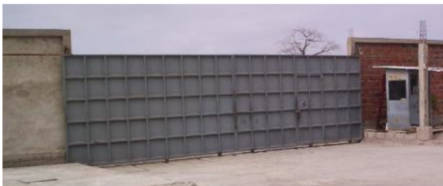
Fotografía. 1.2. Puerta de entrada a la planta de EnergyAlt
