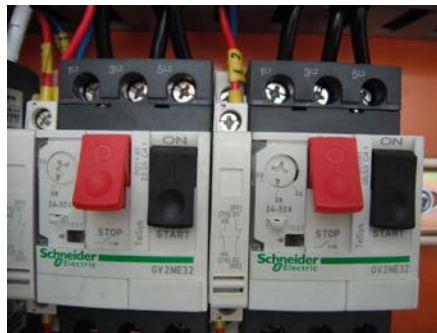
Foto.3.13: Auxiliares de guardamotor Fuente: Empresa AYMESA S.A 2012
