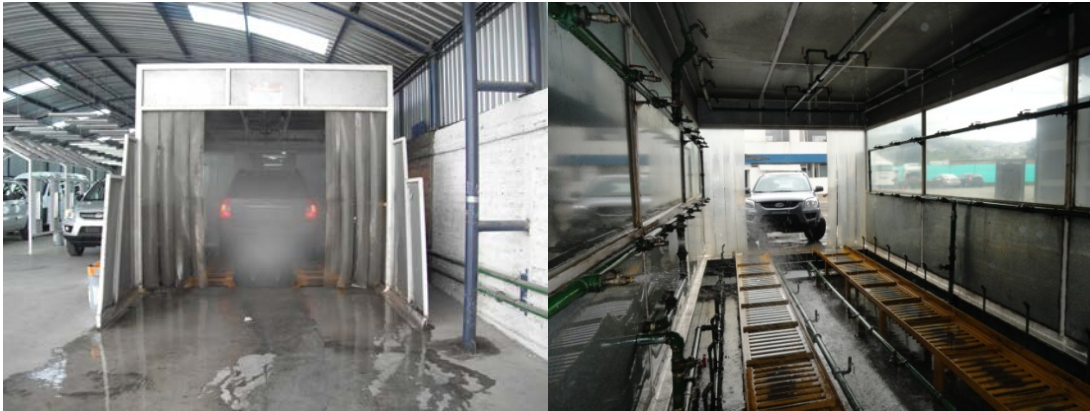
Foto.3.2: Ingreso de la unidad Fuente: Empresa AYMESA S.A 2012
