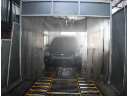
Foto.2.4: Cabina de agua (calidad) Fuente: Empresa AYMESA S.A 2012
