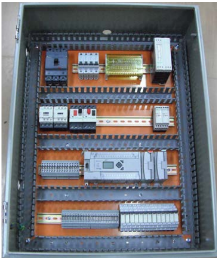
Foto.3.6: Instalación de dispositivos Fuente: Empresa AYMESA S.A 2012
