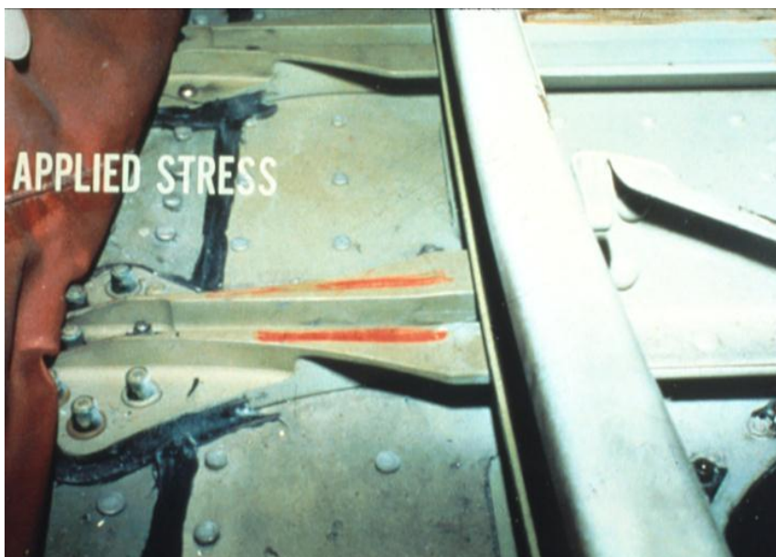
Figura 2.15: Corrosión fisura por esfuerzo
