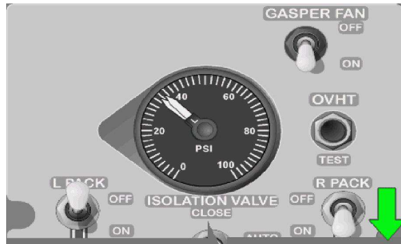
FIG 2.7: Switch de operación de la válvula pack
