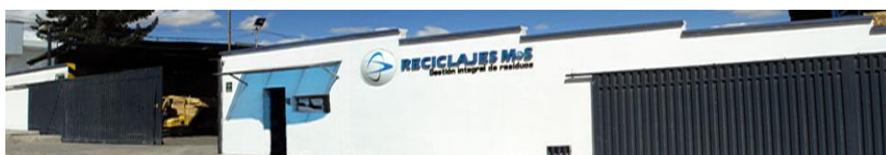
Figura 2 Instalaciones de la empresa Reciclajes MYS matriz Quito. Fuente: www.reciclajesmys.com
