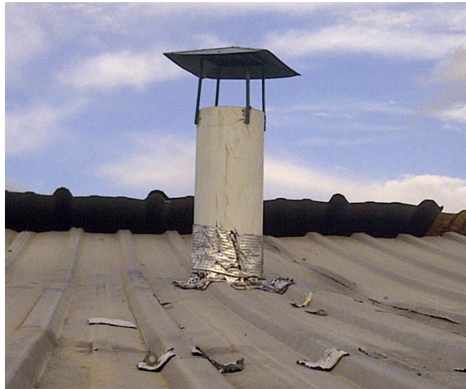
Figura 0.37: Montaje de la techera.
