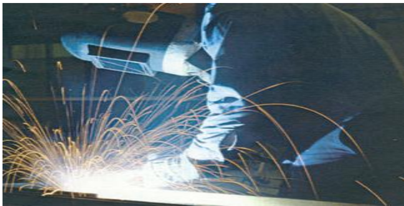
Figura 0.10: Proceso de Soldadura con arco eléctrico.
