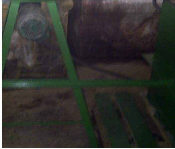
Figura 0.34: Montaje de la Estructura.
