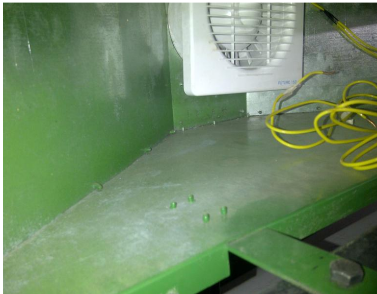
Figura 0.38: Montaje del Extractor.
