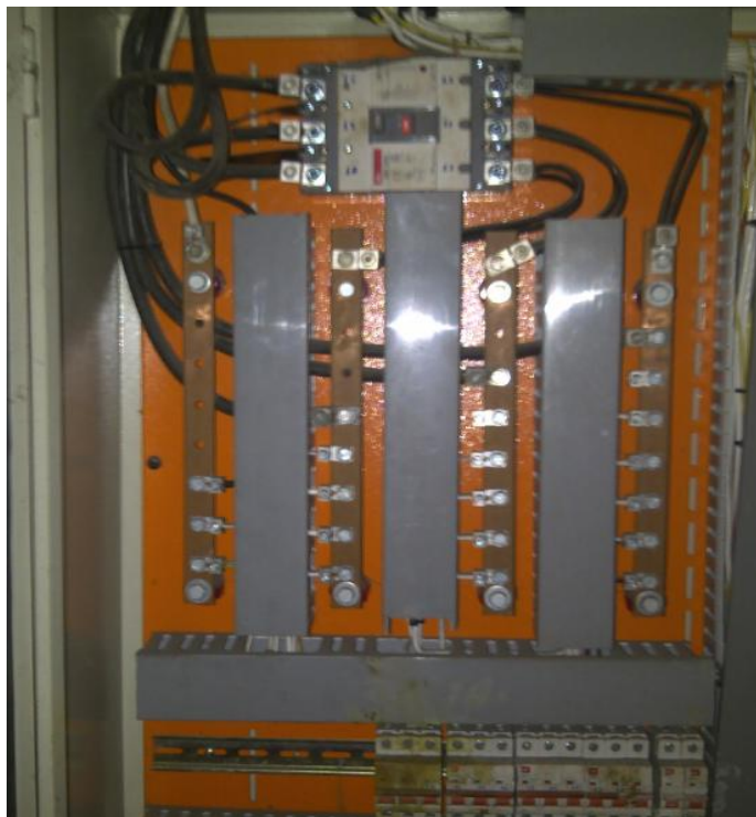
Figura 0.31: Instalación del Tablero de Protección.
