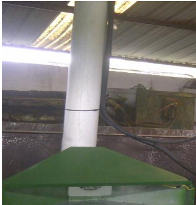
Figura 0.36: Montaje de los Ductos.
