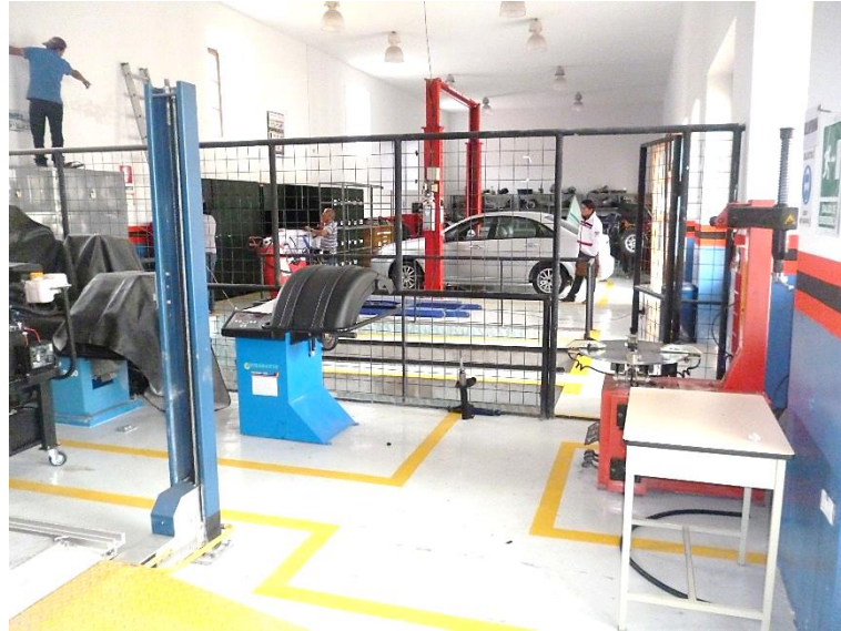
Figura 3. 34 Trazado de líneas de seguridad finalizado
