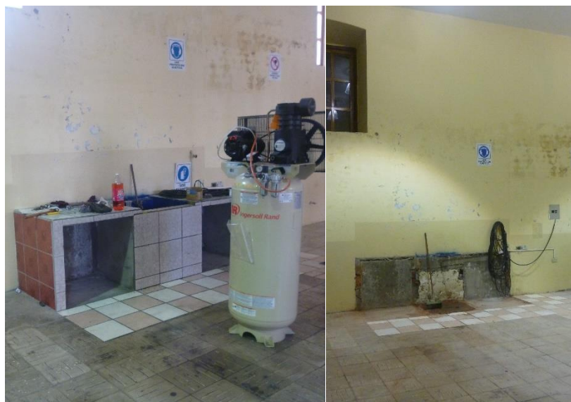
Figura 3. 17 Eliminación del lavamanos
