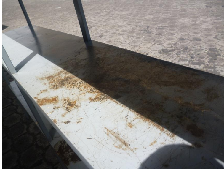
Figura 3. 23 Estado inicial de las estanterías y mesas de trabajo
