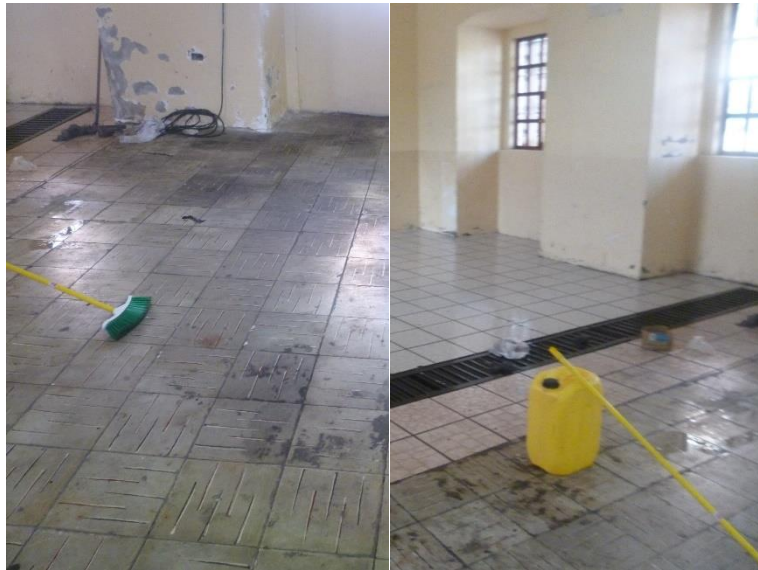
Figura 3. 18 Limpieza y descontaminación del piso
