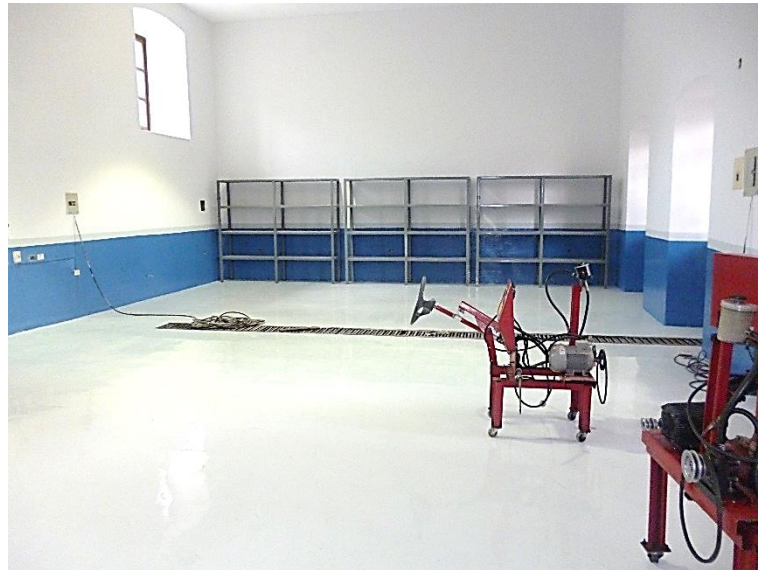
Figura 3. 22 Piso epóxico
