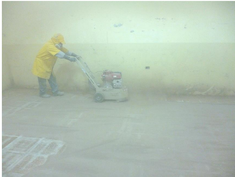
Figura 3. 20 Fase de pulido del piso
