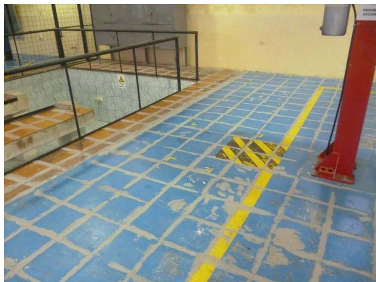
Figura 3. 19 Masillado de las uniones de la baldosa
