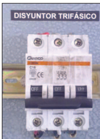
Foto 6.24: Disyuntor trifásico Fuente: Módulo de Control Industrial Elaborado por: Cbos. Guanín Roberto
