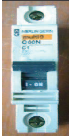
Foto 6.25: Disyuntor monofásico Fuente: Módulo de Control Industrial Elaborado por: Cbos. Guanín Roberto
