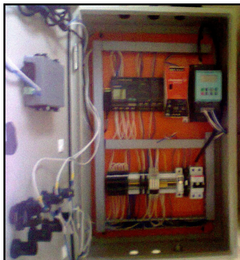
Foto 10. Tablero instalado Elaborado por: Santiago Villavicencio
