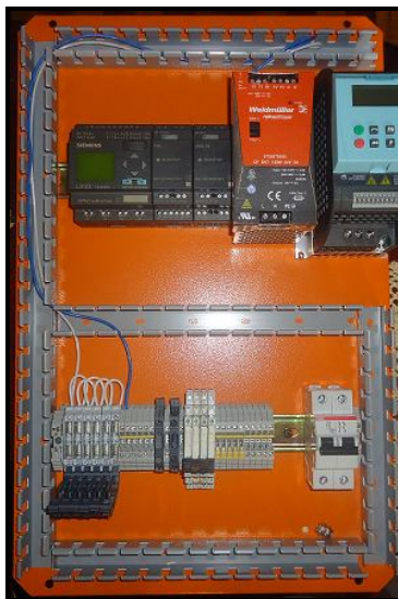
Foto 5. Equipos en el Tablero de Control Elaborado por: Santiago Villavicencio
