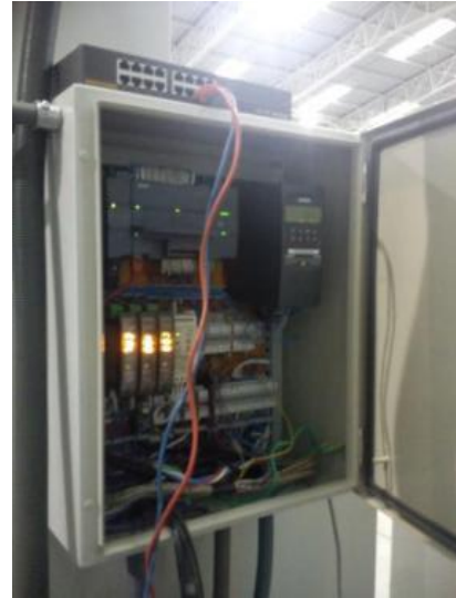
Figura 14. Montaje y pruebas del tablero de control
