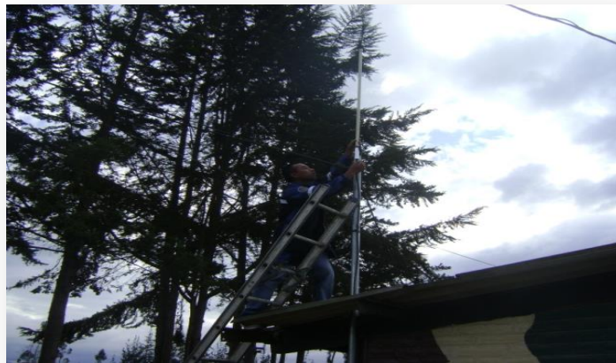
Figura 4.35: Instalación de la Antena.
