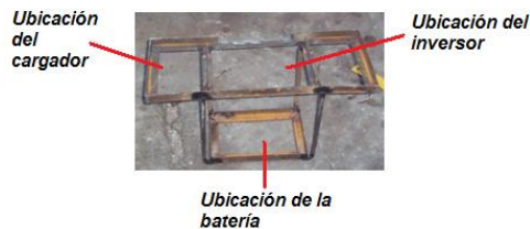
Bases para elementos eléctricos.
